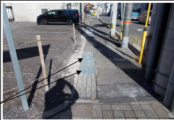
補修後の状況
